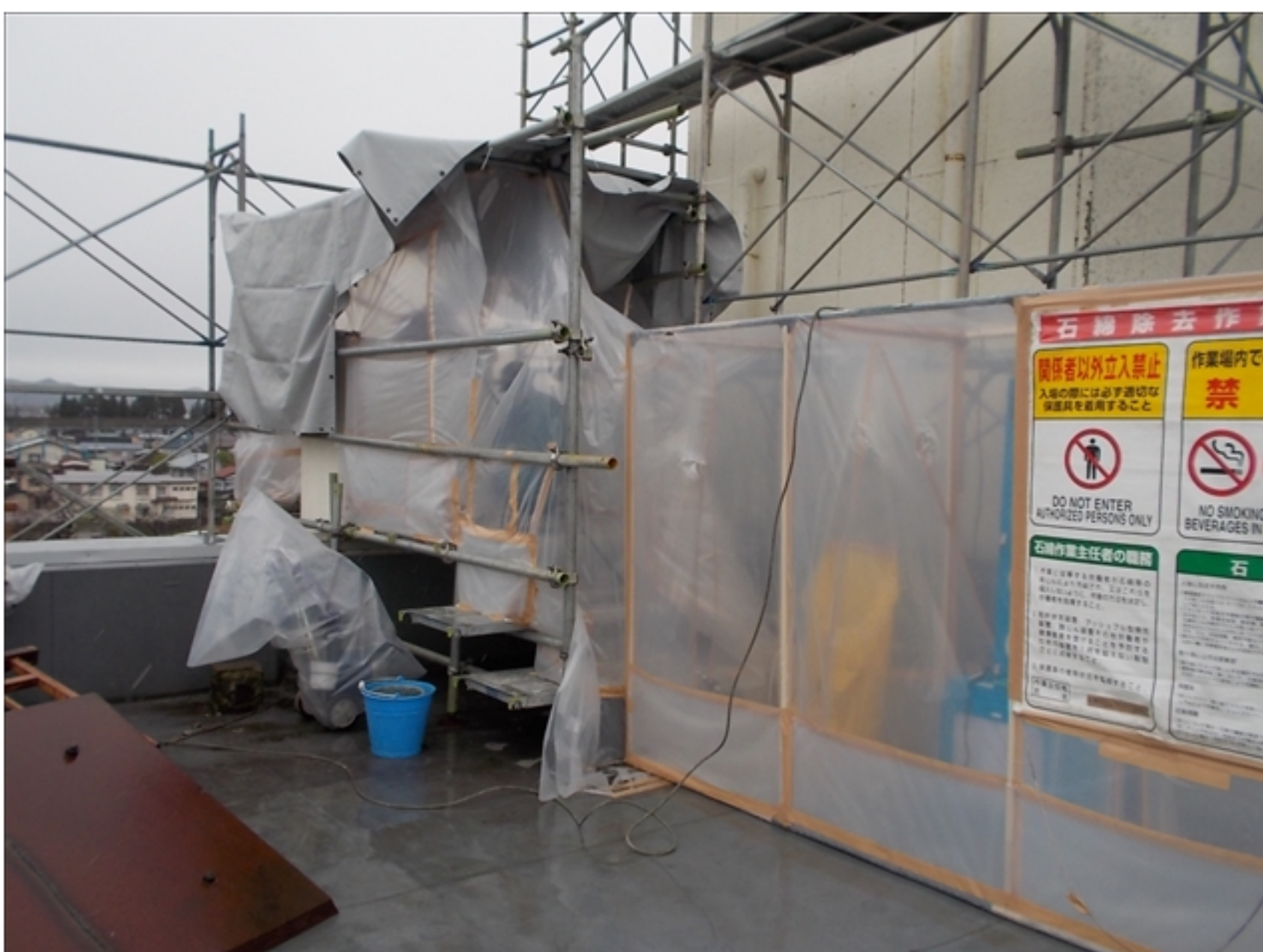
工事種目：アスベスト除去作業中
