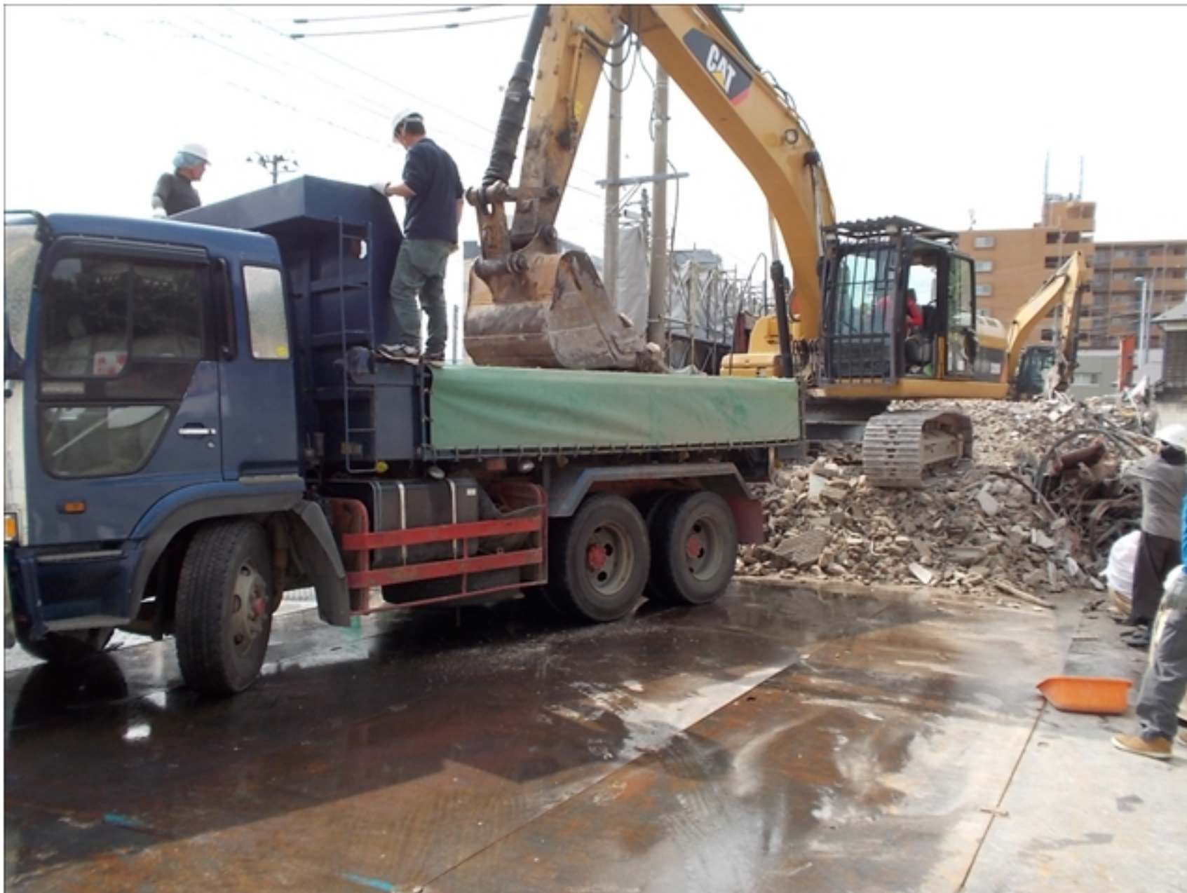
工事種目：コンガラの搬出
