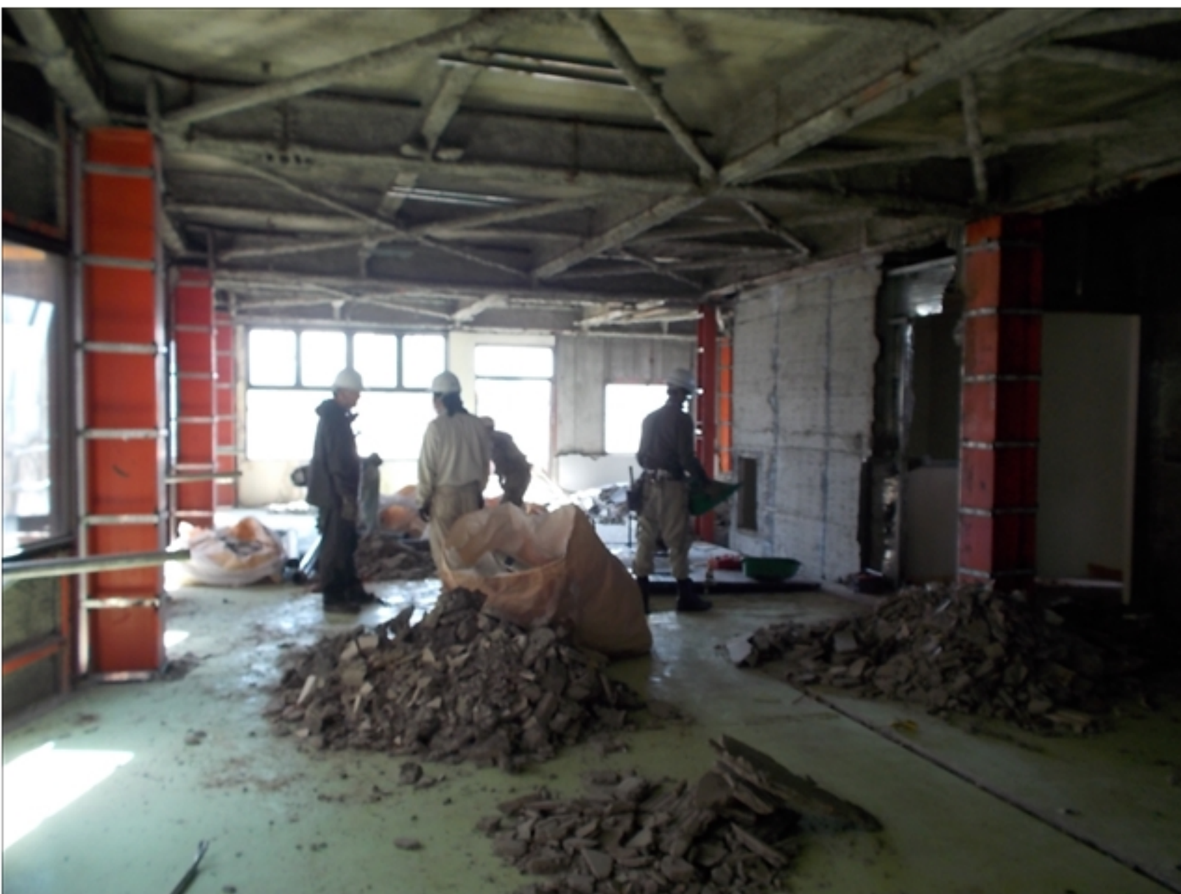
工事種目：内装材搬出
