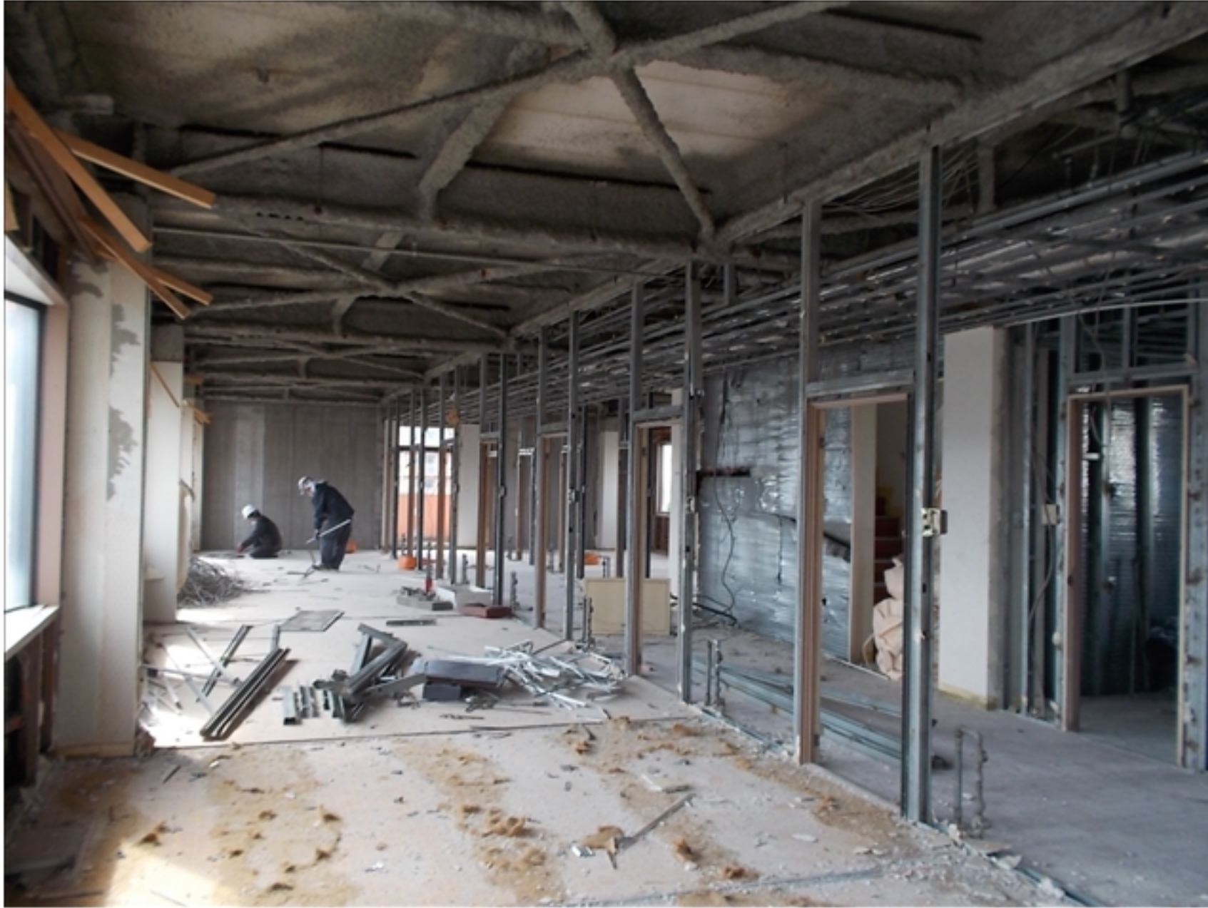
工事種目：内装解体
