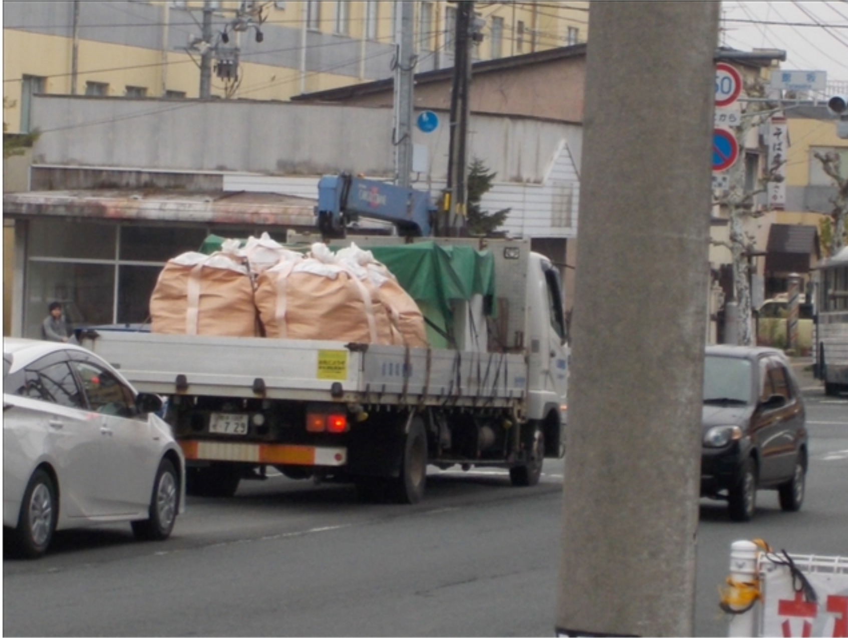
工事種目：アスベスト搬出
