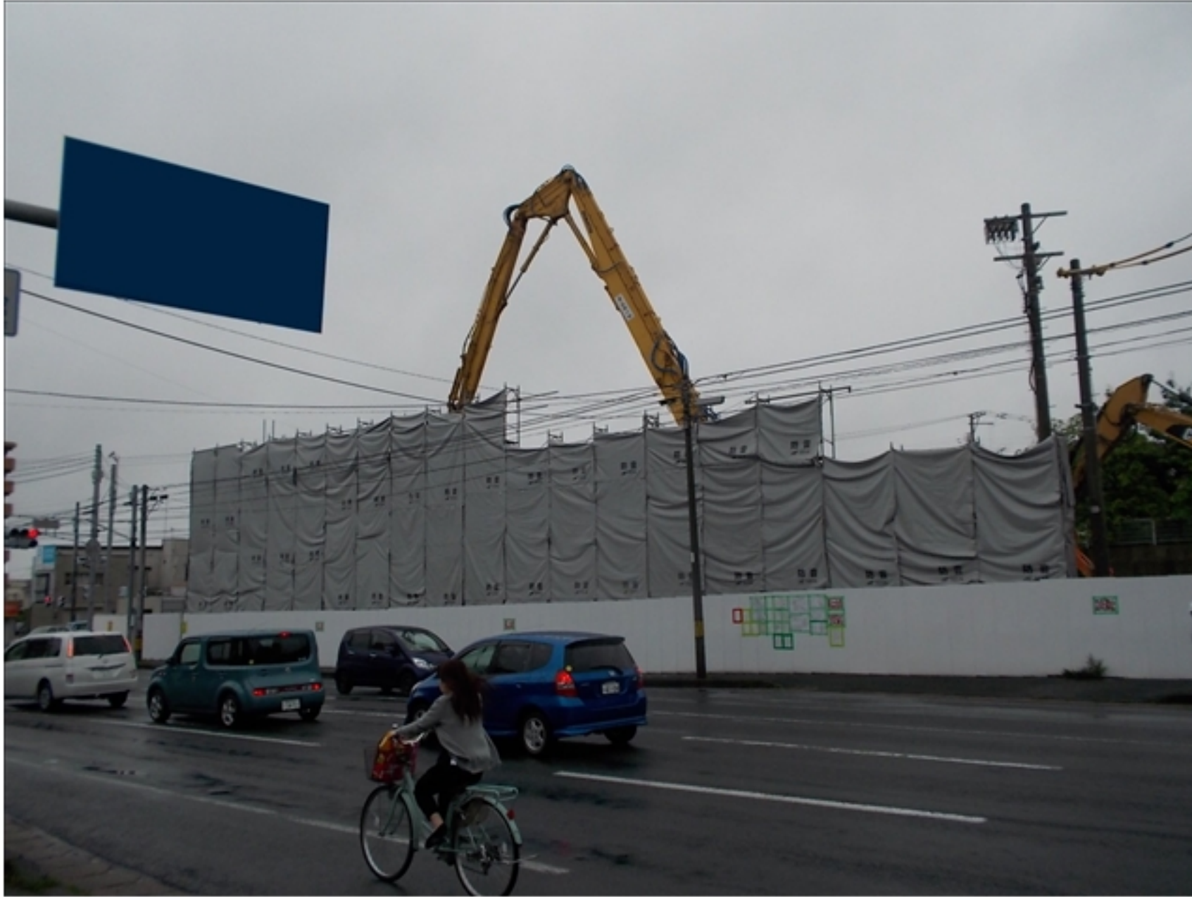
工事種目：重機解体 状況に応じ足場撤去
