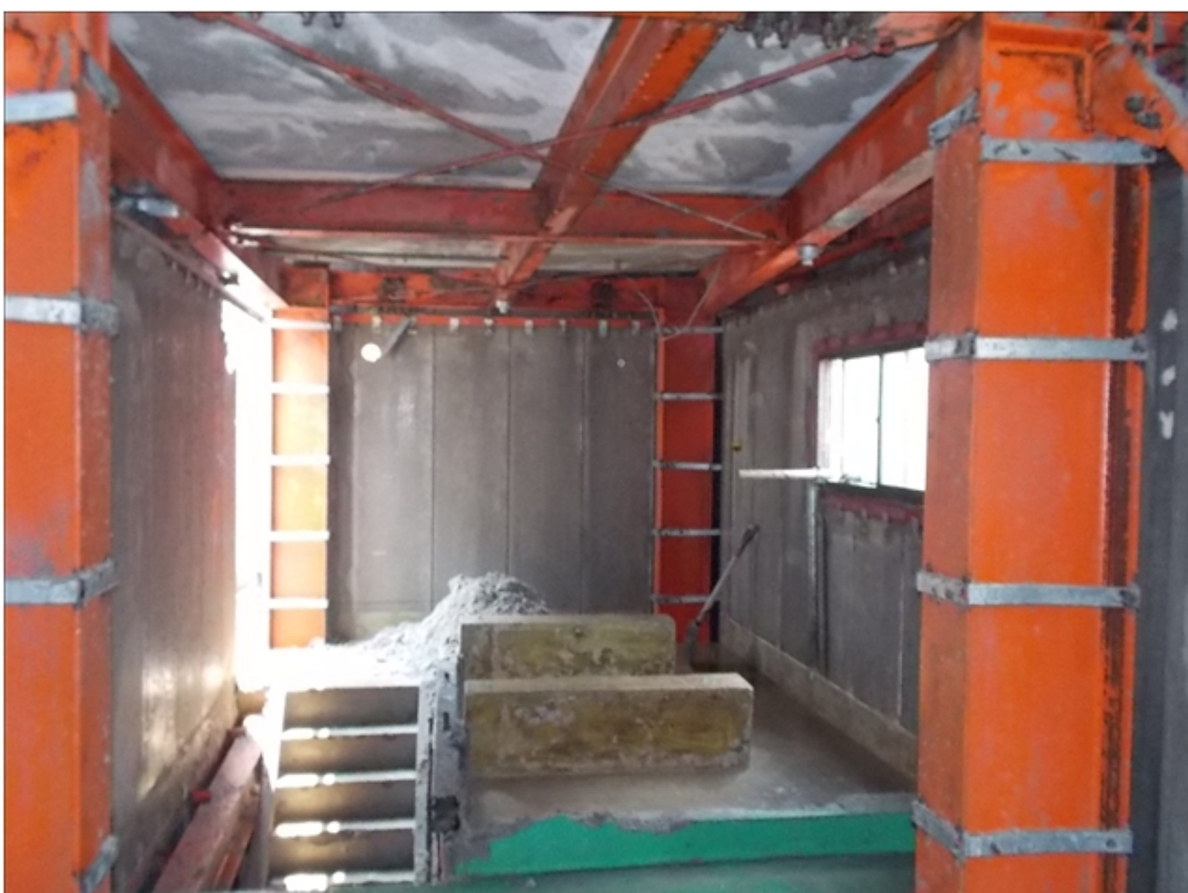
工事種目：洗淨完了
