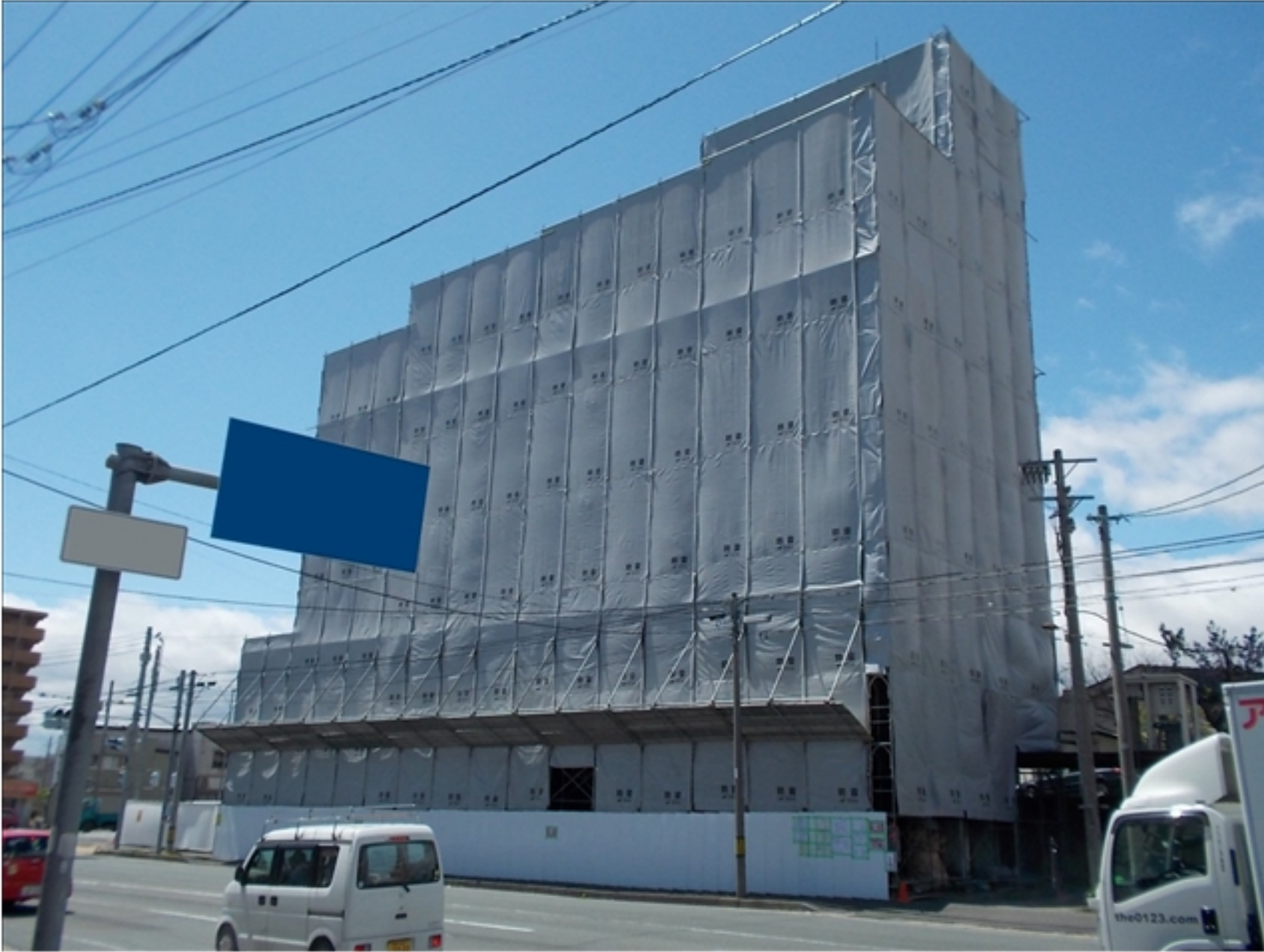
工事種目：養生シート張り
