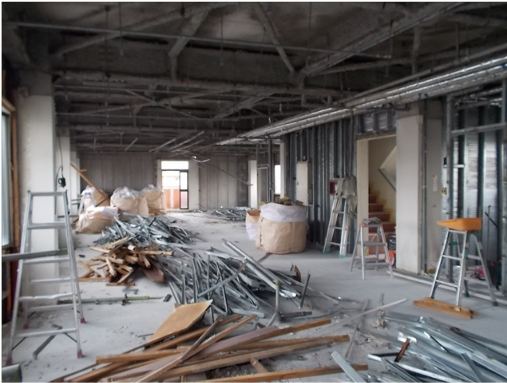
工事種目：内装解体
