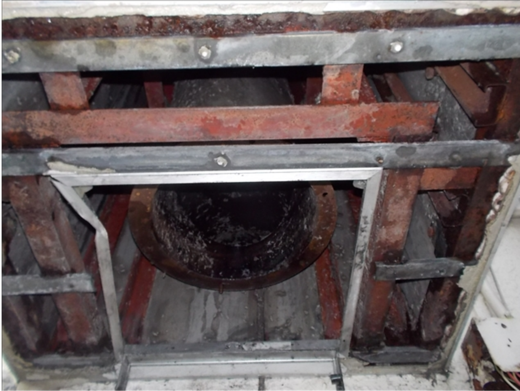
工事種目：煙突部 下部より
