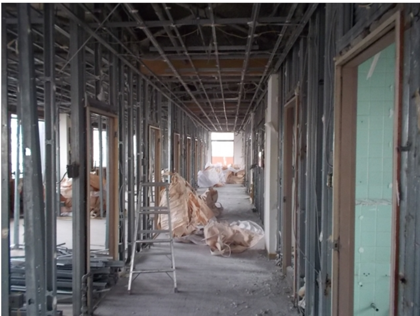
工事種目：内装解体
