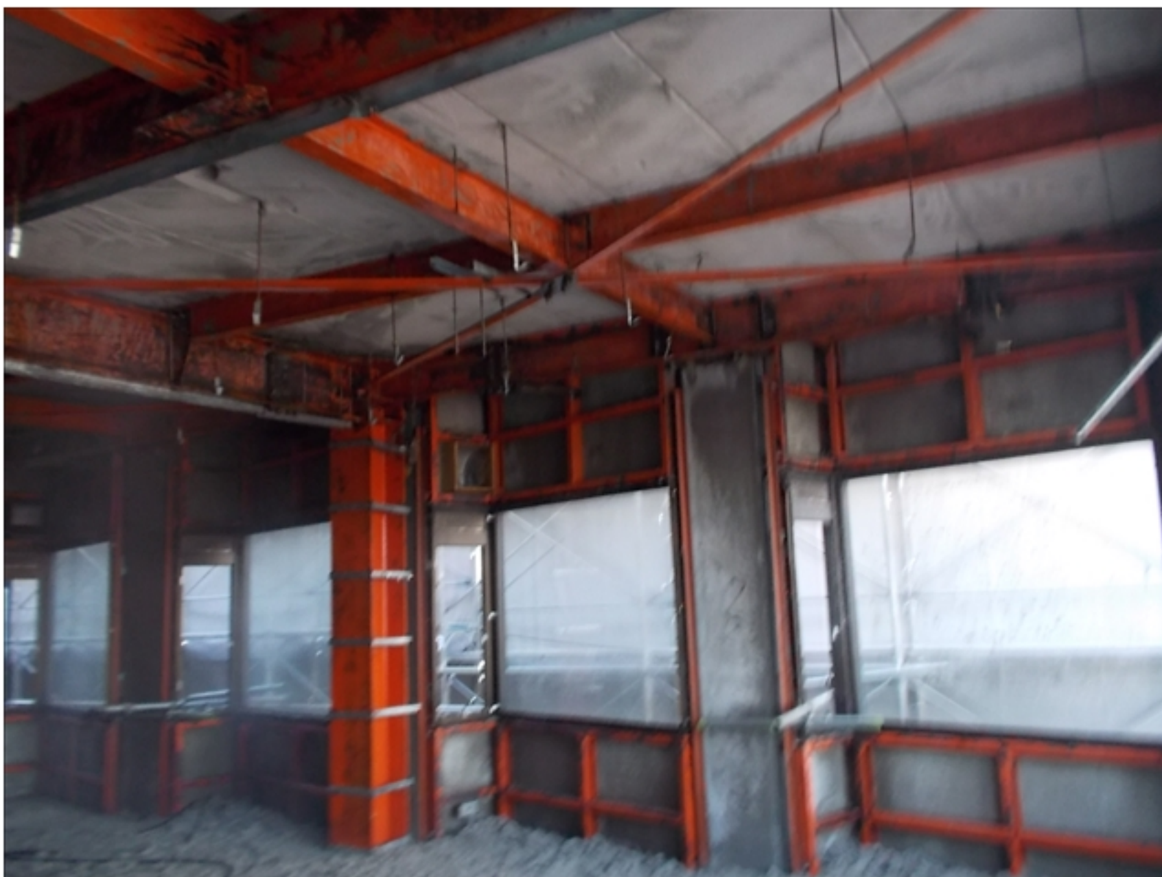
工事種目：洗淨完了
