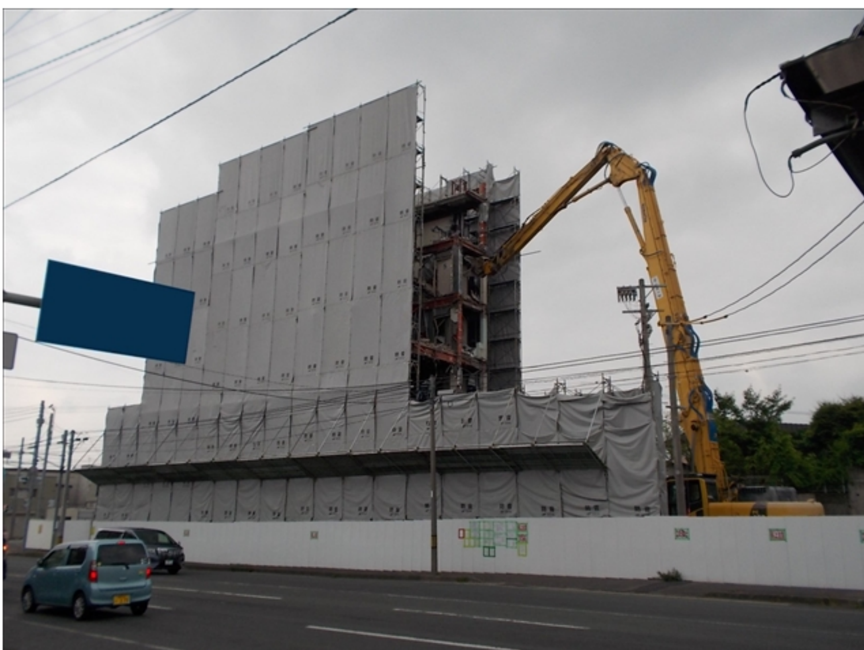
工事種目：重機解体状況
