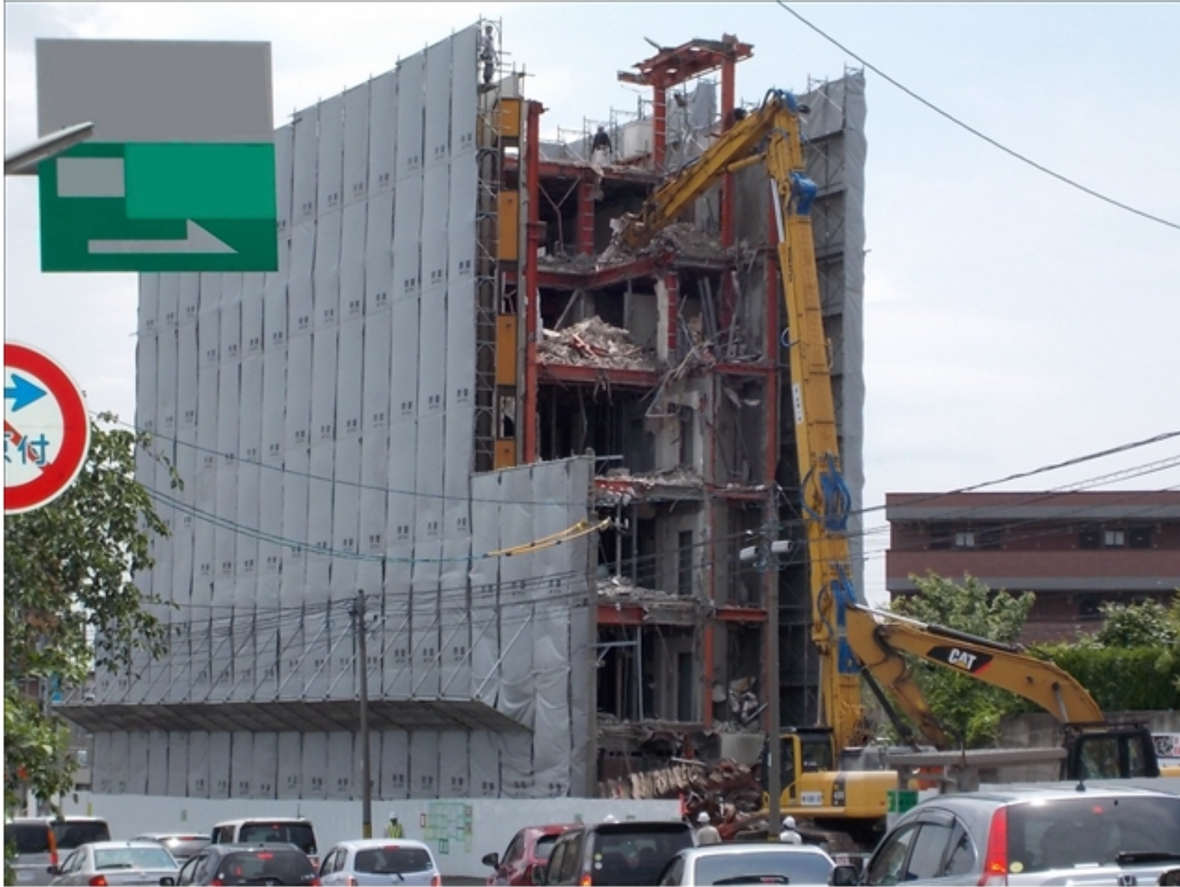
工事種目：重機解体 450ハイリフトにて解体
