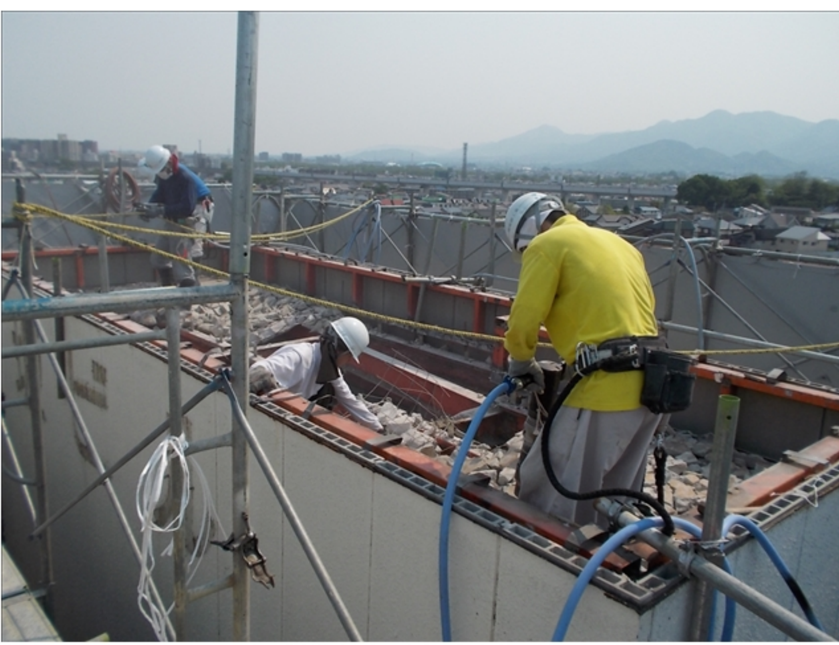
工事種目：塔屋斫り
