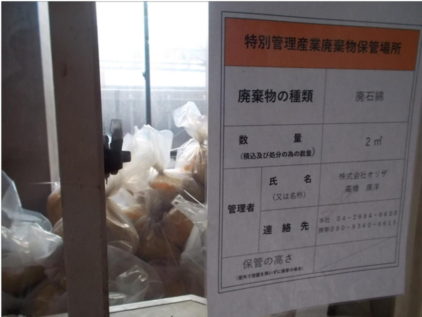
工事種目：アスベスト保管場所
