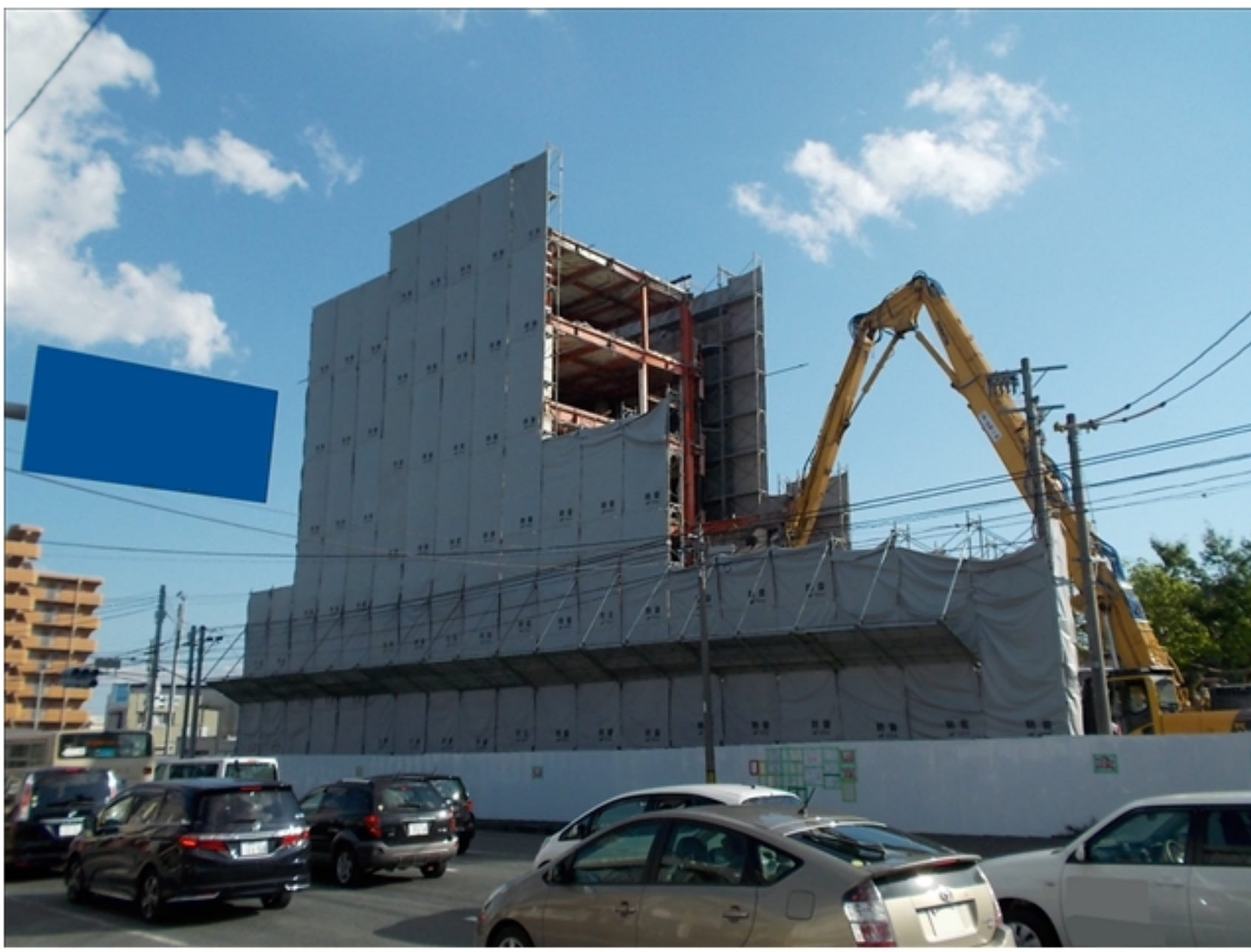
工事種目：重機解体 状況に応じ足場撤去
