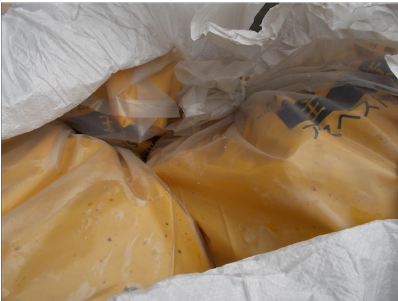
工事種目：アスベスト積込み
