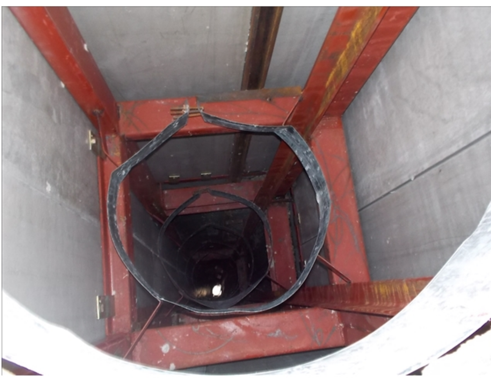
工事種目：煙突部作業後
