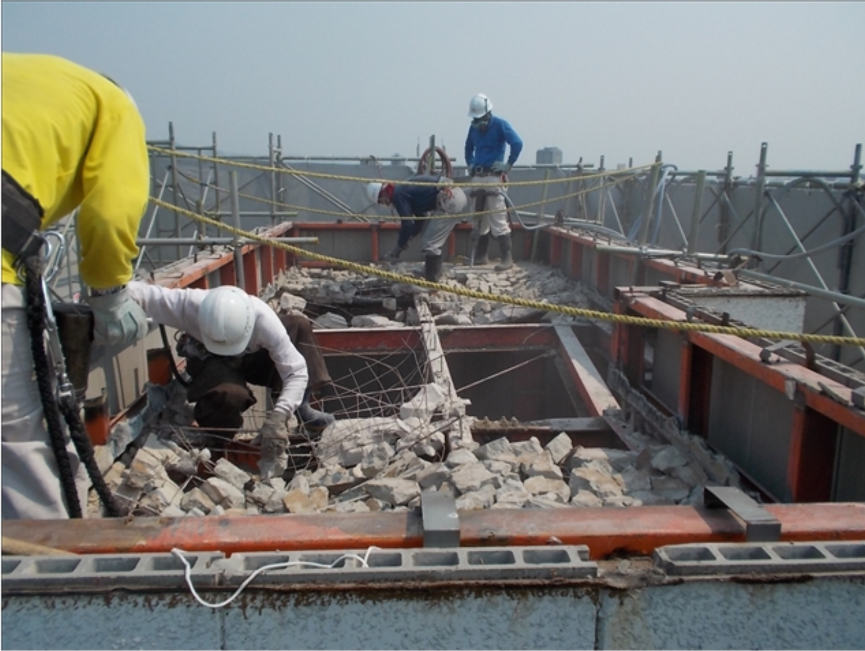
工事種目：塔屋斫り
