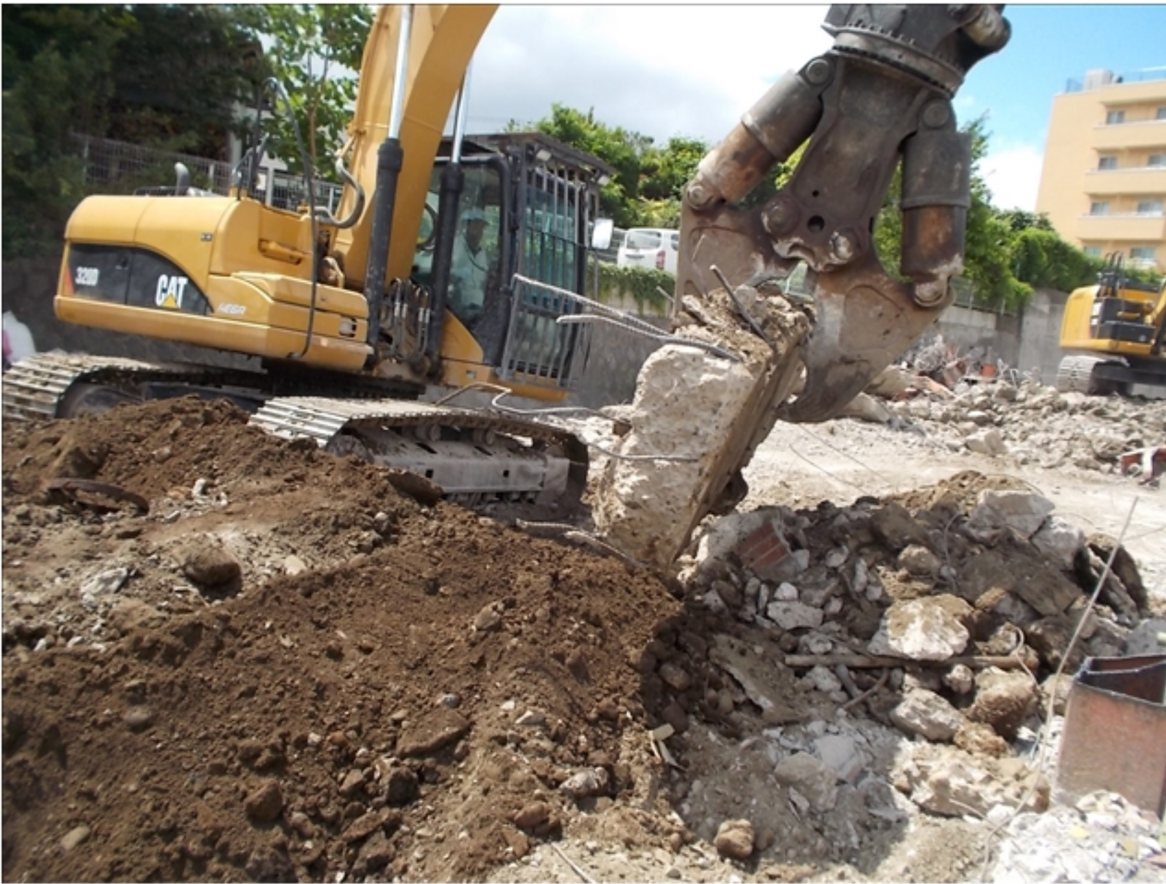
工事種目：土間基礎解体
