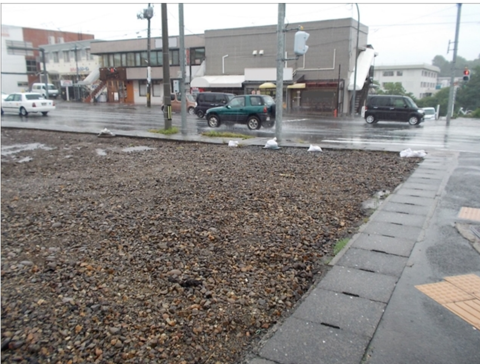
工事種目：工事完了
