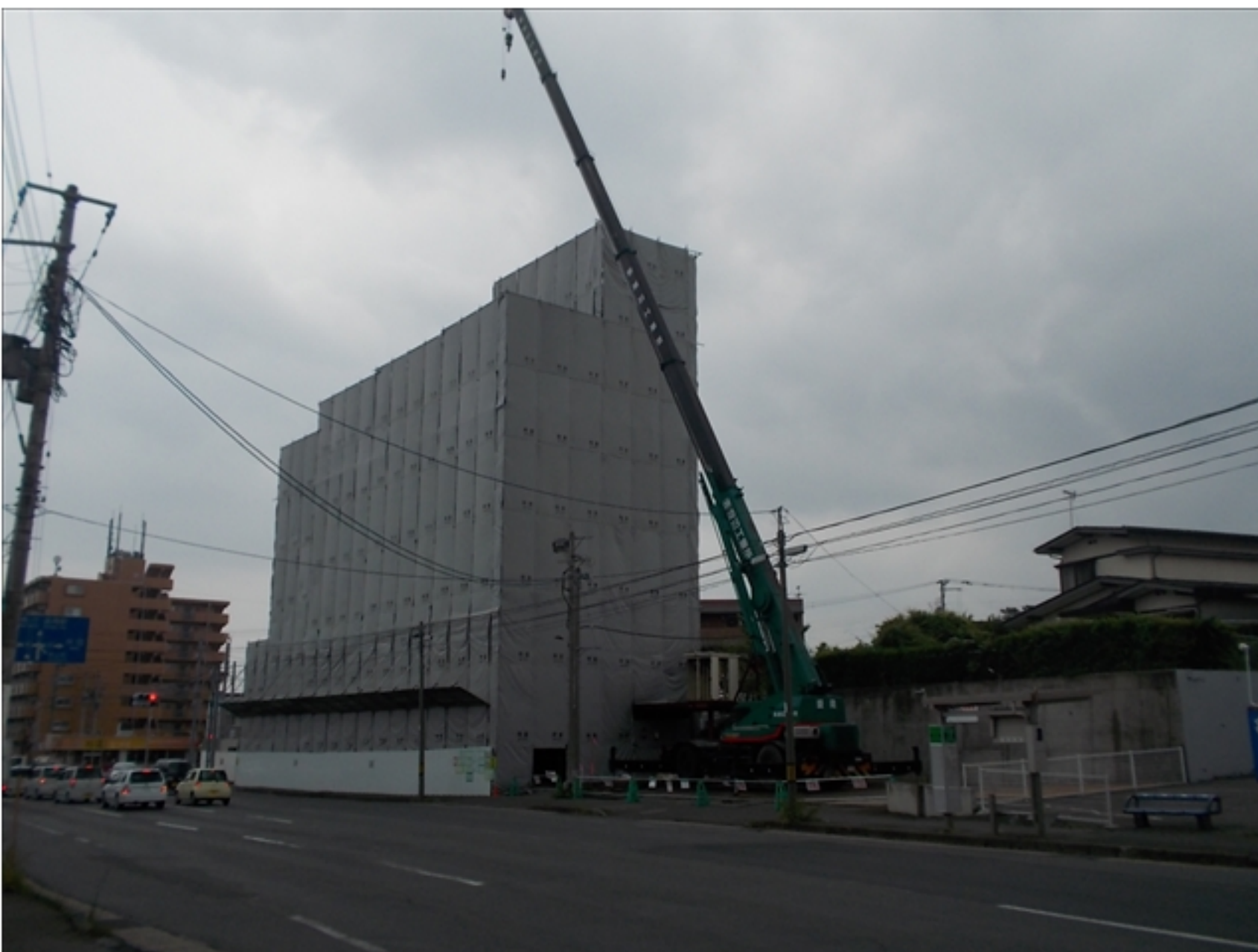
工事種目：60 t クレーンにて荷降ろし
