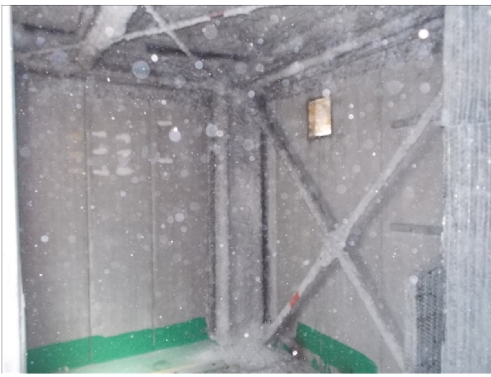
工事種目：洗淨前
