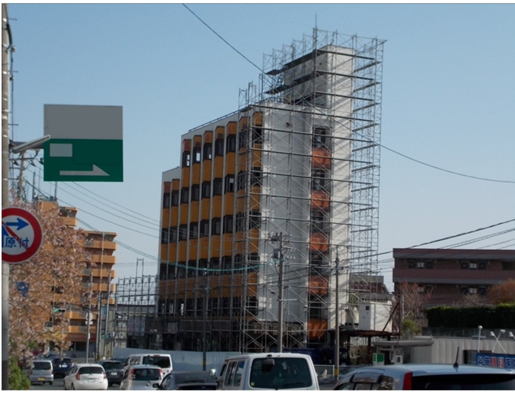
工事種目：養生組立
