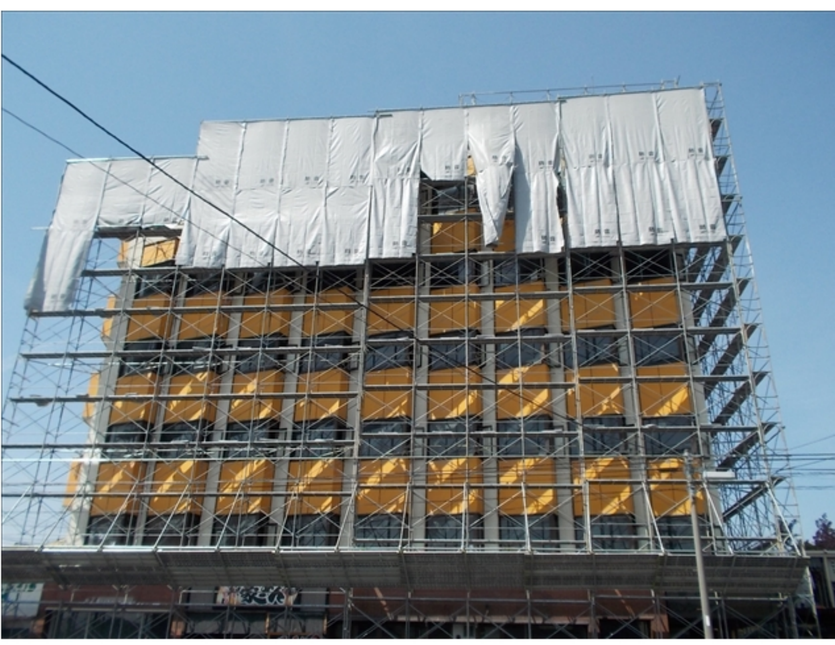
工事種目：養生シート張り
