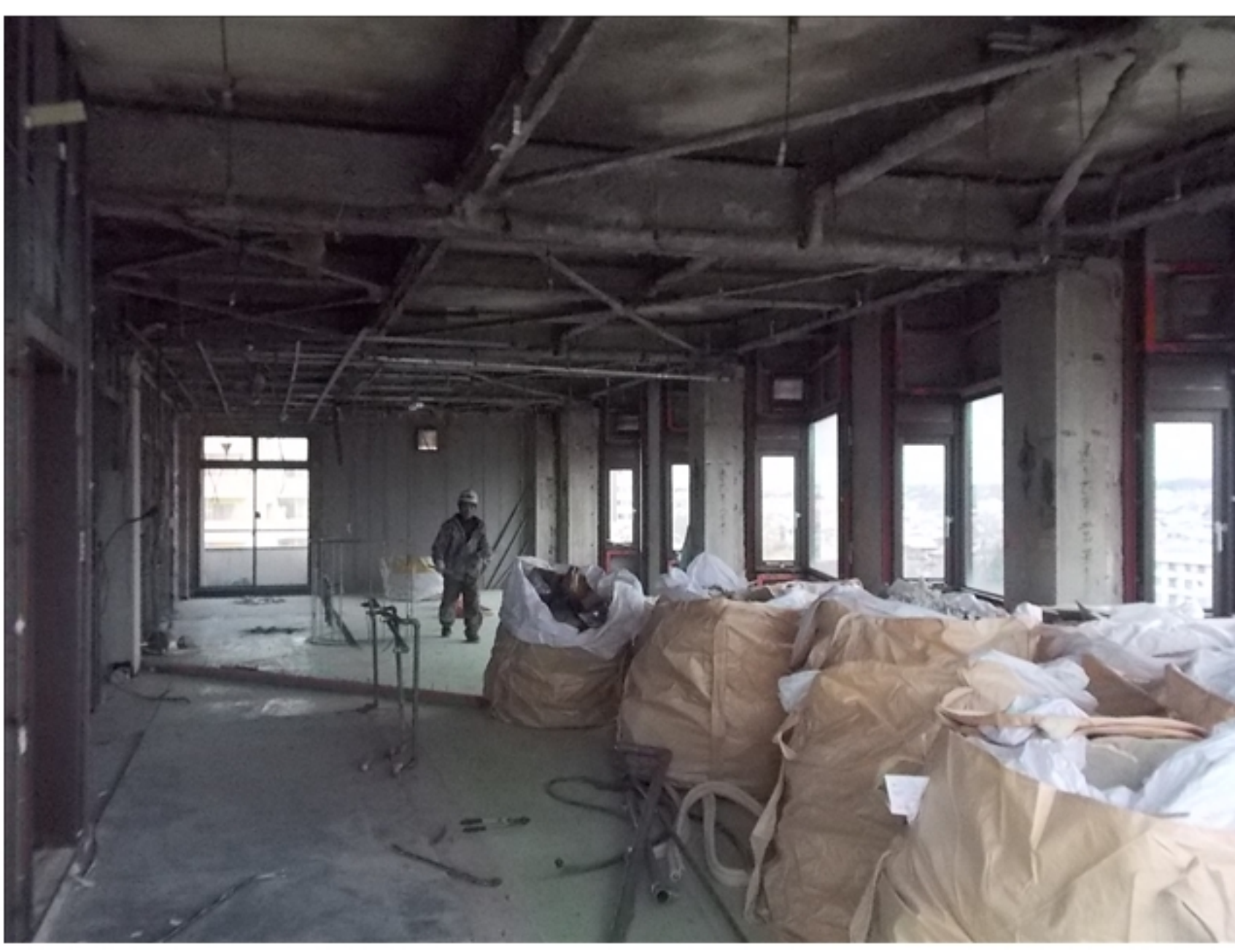
工事種目：内装解体
