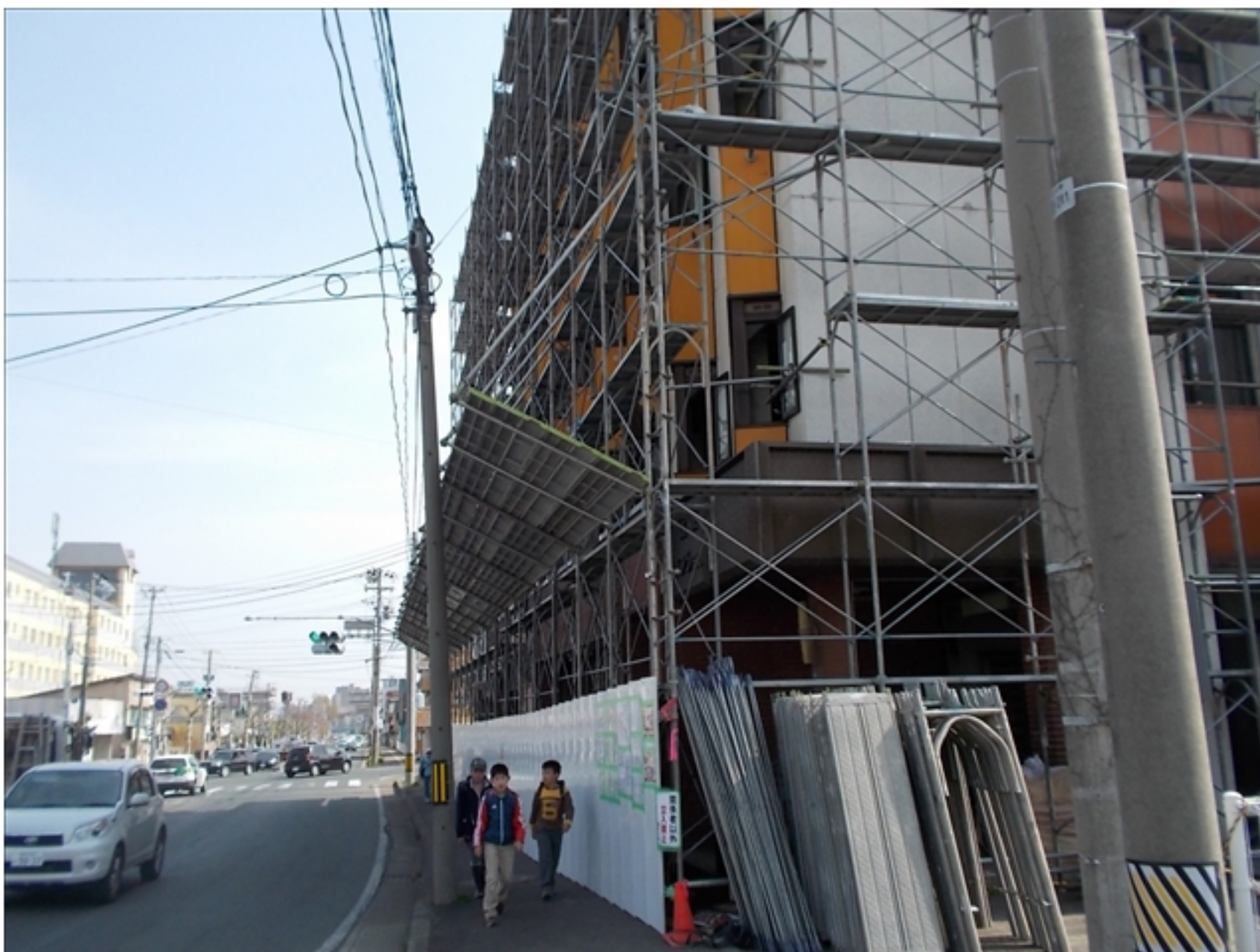
工事種目：養生組立
