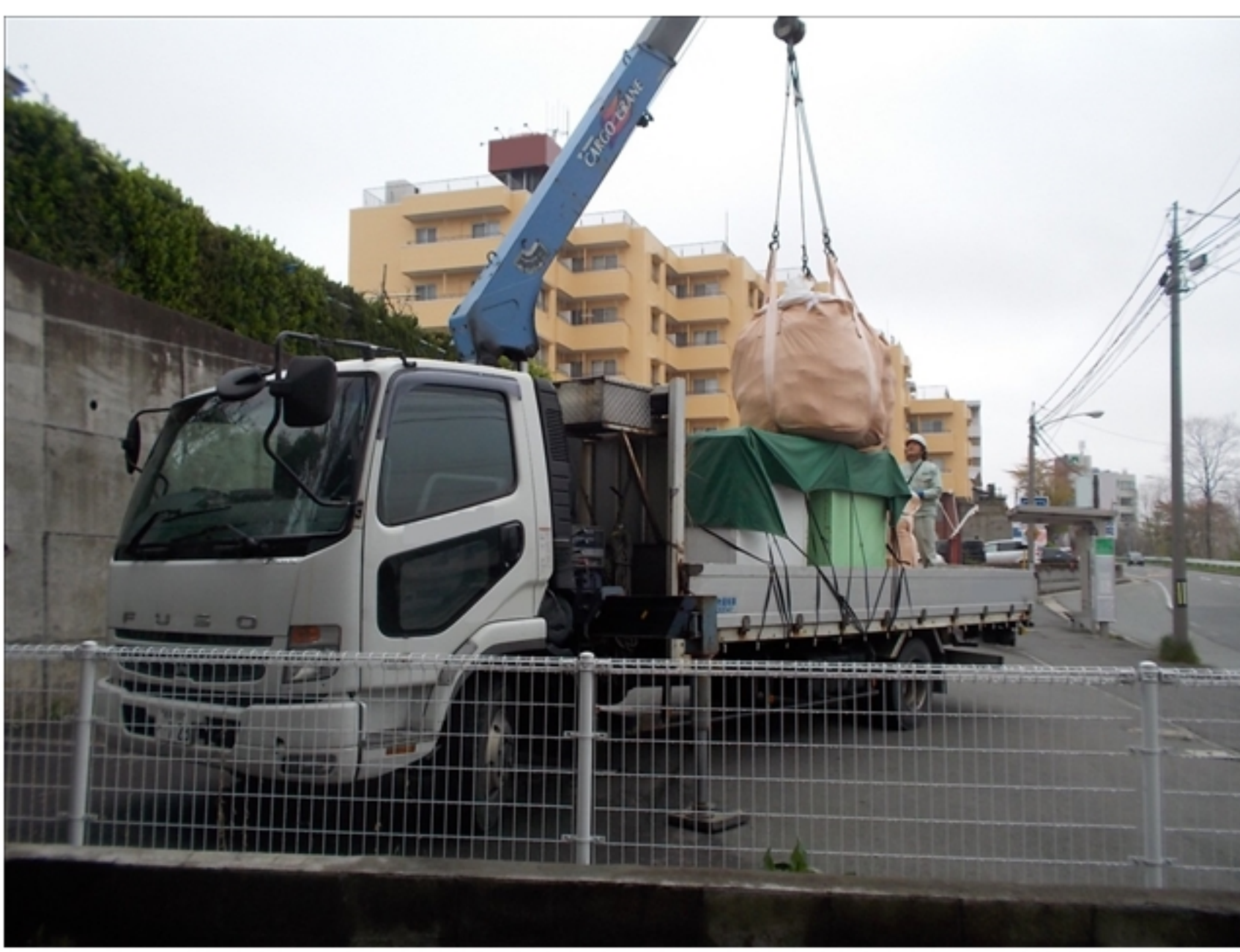
工事種目：アスベスト積込み
