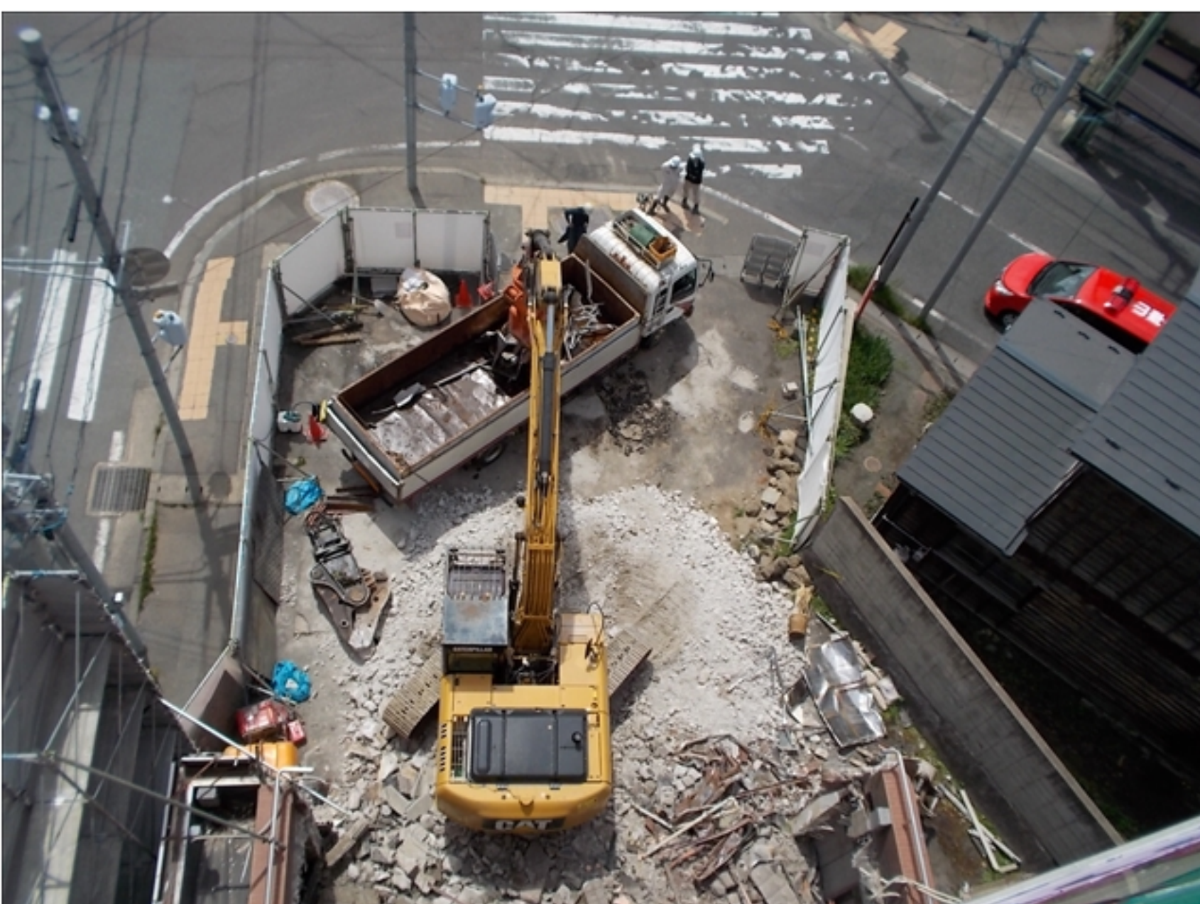
工事種目：重機解体
