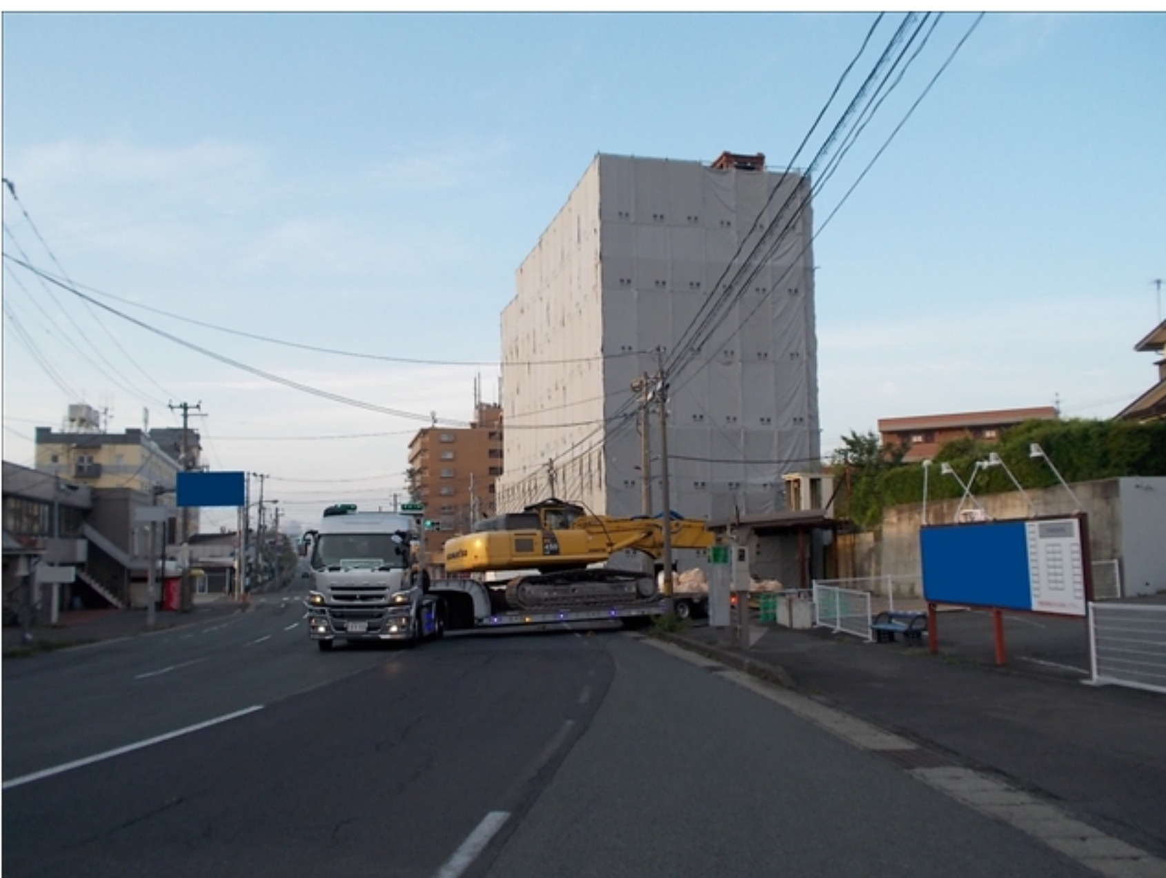
工事種目：重機搬入
