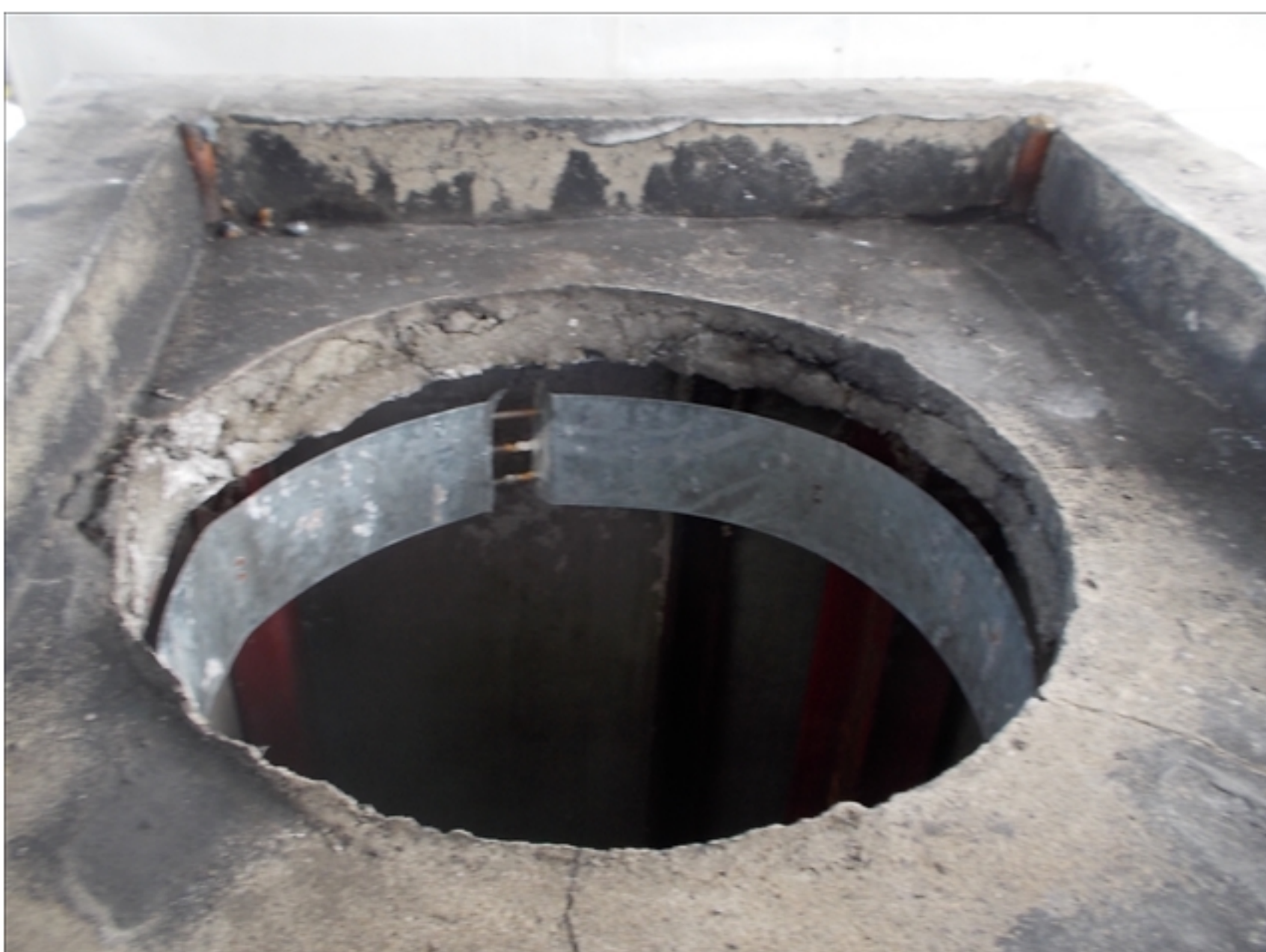
工事種目：煙突部作業前
