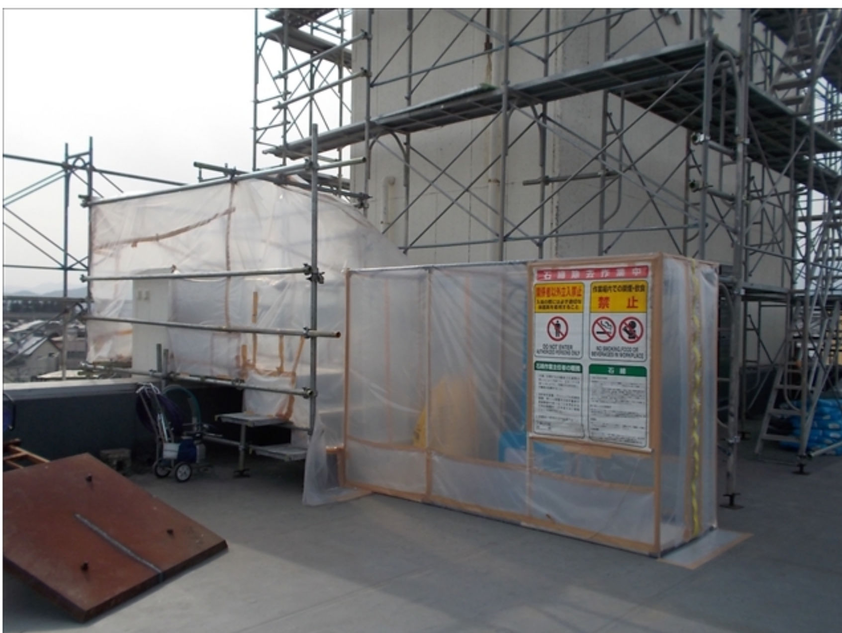
工事種目：アスベスト検査
