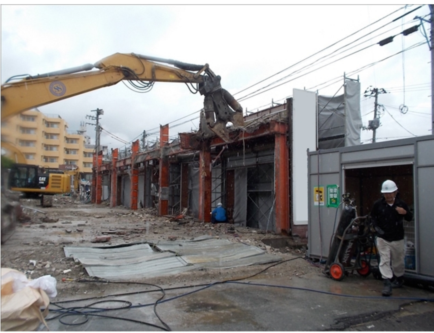
工事種目：1階壁倒し
