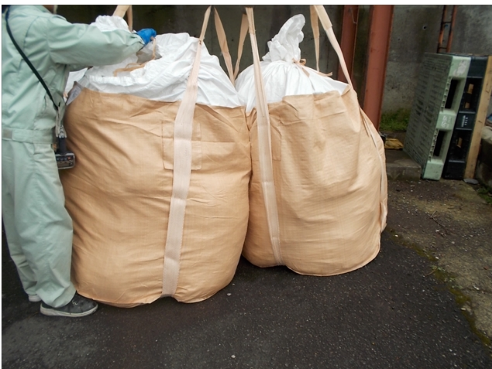
工事種目：アスベスト積込み
