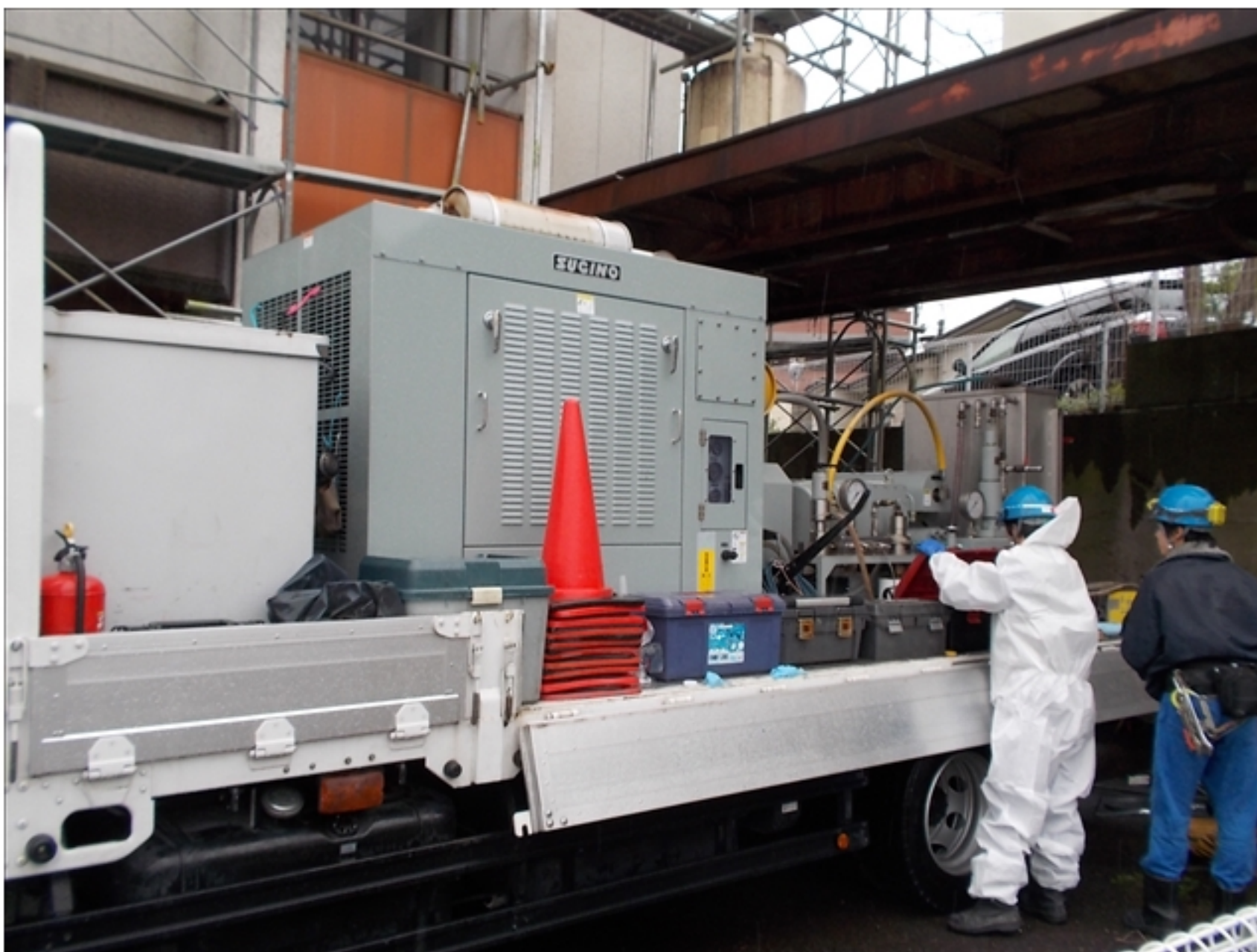
工事種目：アスベスト除去作業中
