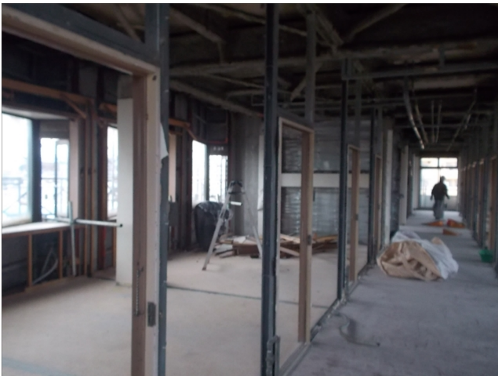
工事種目：内装解体
