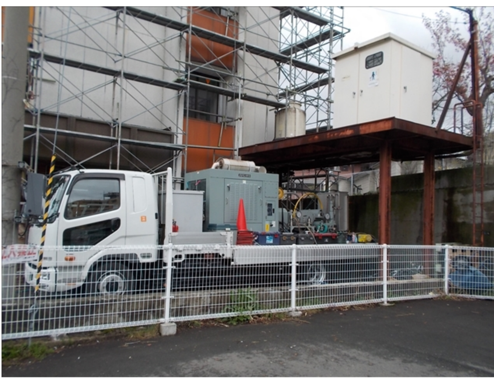
工事種目：アスベスト除去作業中
